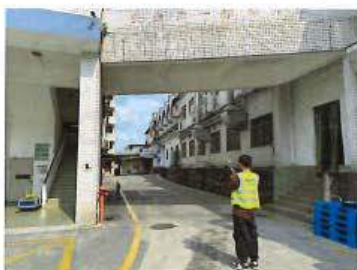
A.B 栋生产车间外监控点 5#
